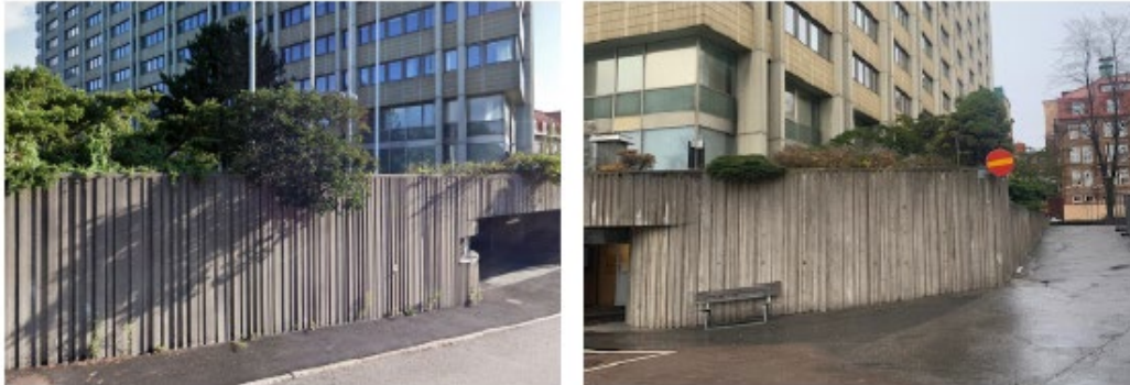
Befintlig betongbalustrad, Wingårdhs, år 2021
