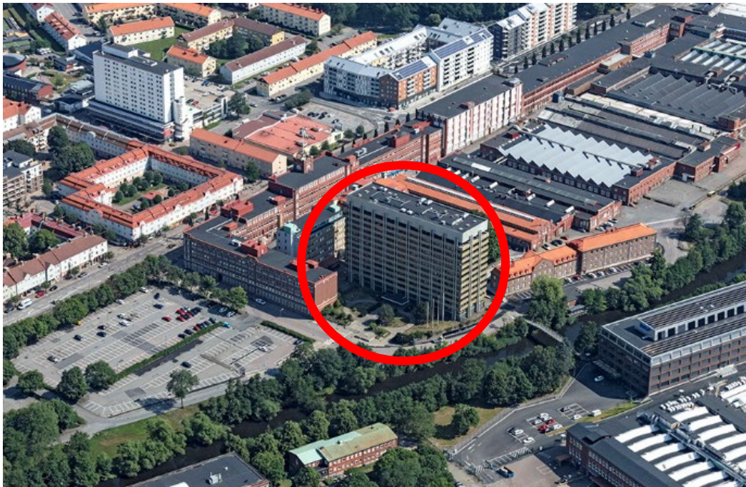
HK3 byggnad med omgivningen i Gamlestaden
