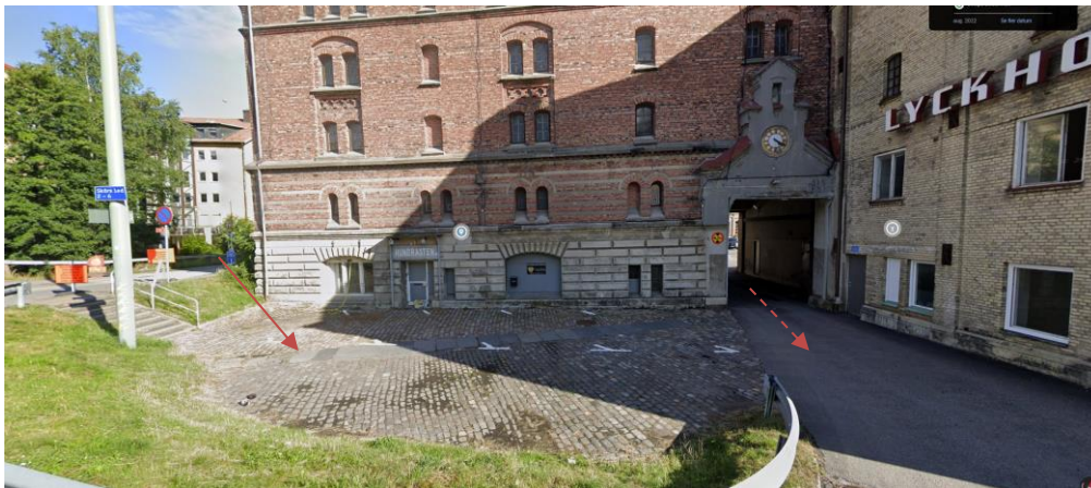
Figur 9 Tröskelpunkt (vid heldragen pil) samt passage via byggnad (streckad pil) som identifieras som ytterligare problempunkt. Bild hämtad från Google maps 2023-09-12. Bild riktad norr ut från Skårs Led.
