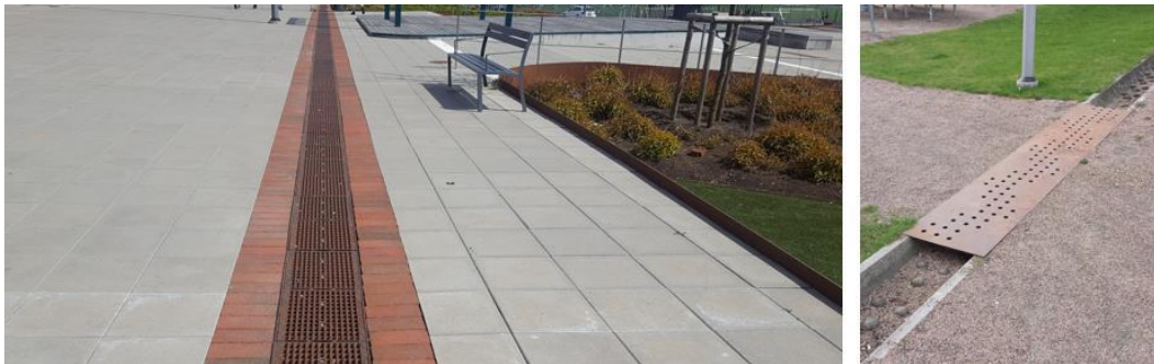
Figur 52 Rännor för transport av dagvatten.
