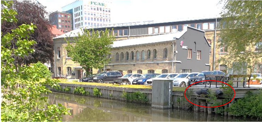
Figur 17 Utloppsledningarna ifrån pumpstationen vid Mölndalsån. Utloppsledningarna placering är markerade med röd cirkel (Ramboll 2020).
