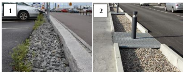
Figur 54 Exempel på krossdikesutformning längs parkeringsyta (1) och väg (2)
