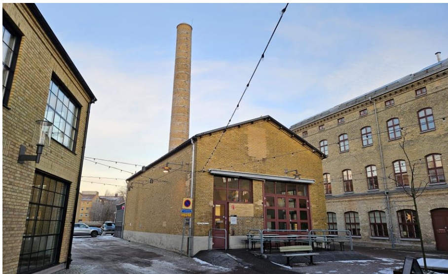
Skorsten samt ångpannehus. Fasad mot söder.
