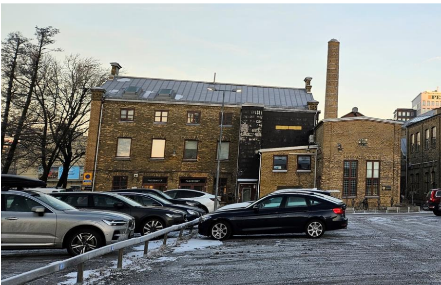
Färgeriet sett från söder.
