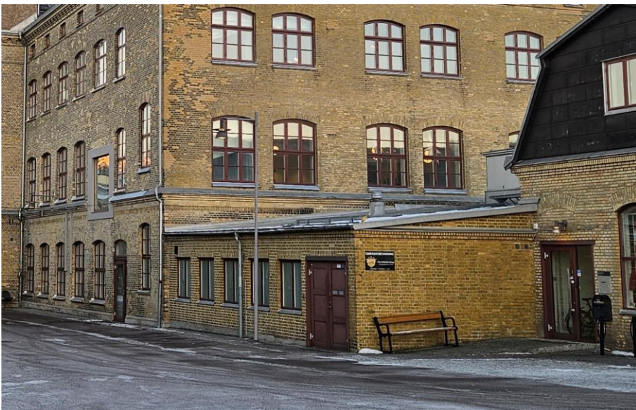
Nya väverikontoret, södra samt västra fasaden.
