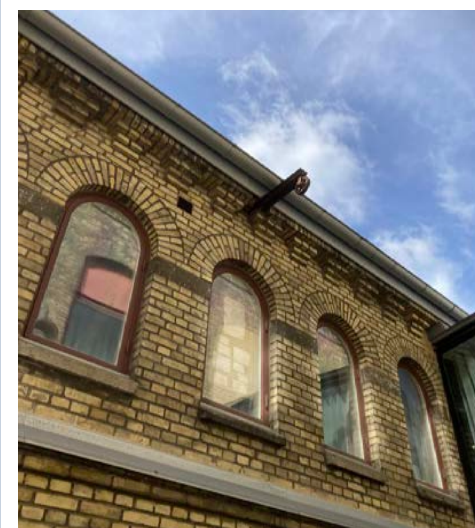
En rest av en hissanordning i gränsen mellan kontoret och Strykjärnet.
