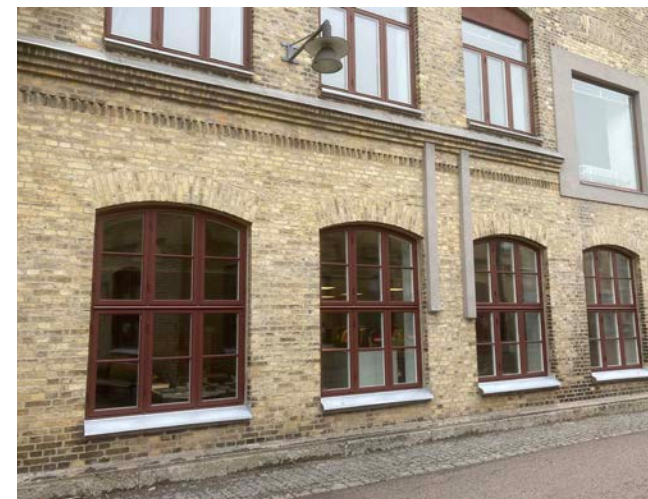
Detaljbild av nya fönster i bottenplan. Även ett nytt fönster i avvikande material och stil har satts in.
