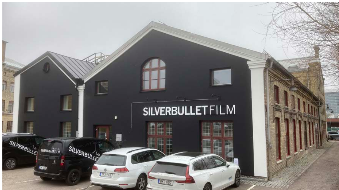
Fasaden mot norr, den lägre, äldsta delen till höger och till vänster en senare tillbyggnad.
