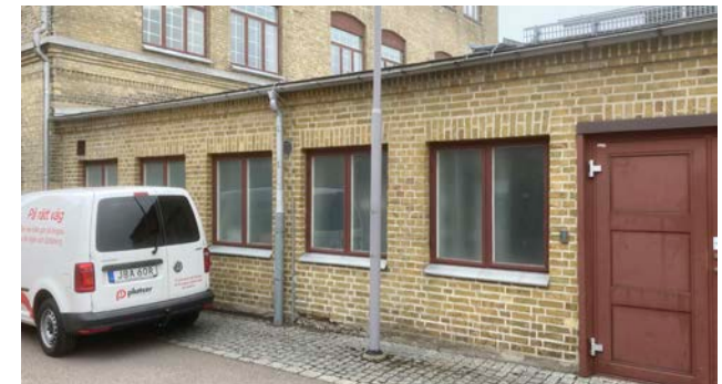
Närbild mot väster. Fönster är möjligen ursprungliga. Mot öster är motsvarande fönster utbytta till moderna med samma indelning.
