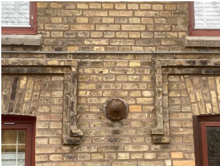
Samma byggnad som ovan, detalj med mönstermurningar och dekor av järn.
