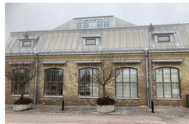
Fasad mot söder. Nya fönster är inrymda inom ursprungliga muröppningar.
