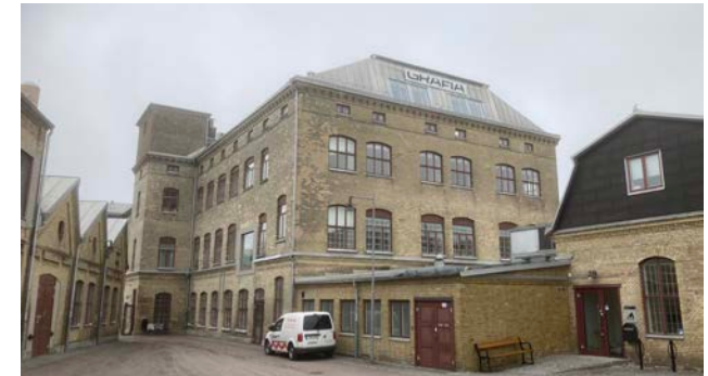
Nya väverikontorets låga tillbyggnad mellan väveri och portvaktshus.
