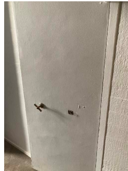
En äldre valvdörr finns kvar i ett av byggnadens rum.
