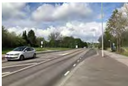
Näsetvägen i höjd med hållplatsläget Hults bro, med Västra Järnbrott i bakgrunden.
