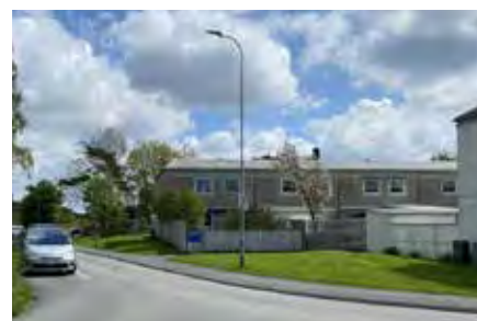
Radhusområde utmed Korsåsliden på Tynneredshöjden
