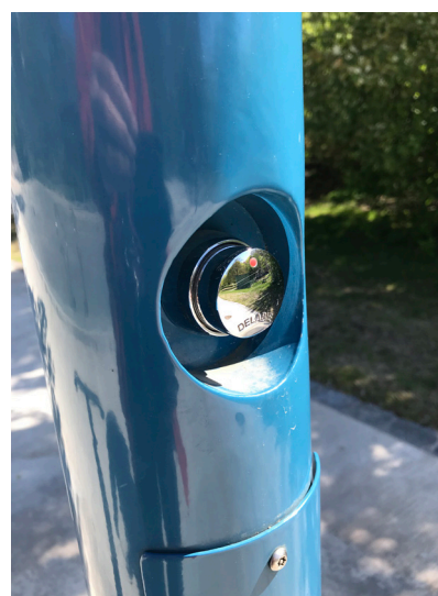
Dusch med infälld tryckknapp
