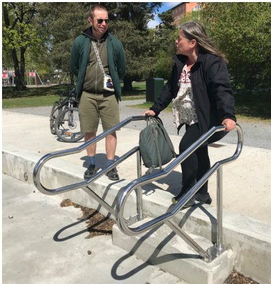
Trappsteg och handledare som underlättar att ta sig ner och upp ur dammen
