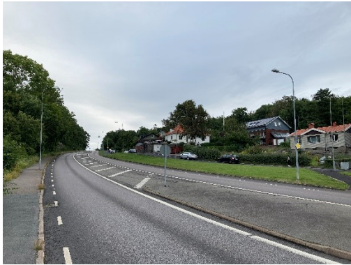
Grevegårdsvägen sedd norrut, SBF
