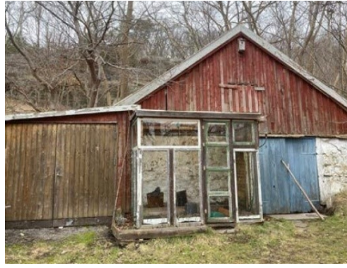
Källarvind med påbyggt garage. WSP
