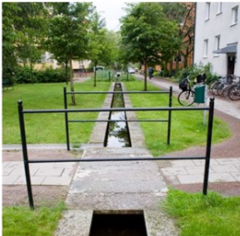
Exempel ränna för dagvatten och skyfall i Augustenborg, Malmö (klimatanpassning.se)
