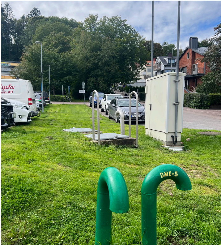
Figur 8. Ett stort U-område går diagonalt under platsen. I nordöstra hörnet finns luckor, skåp och master.
