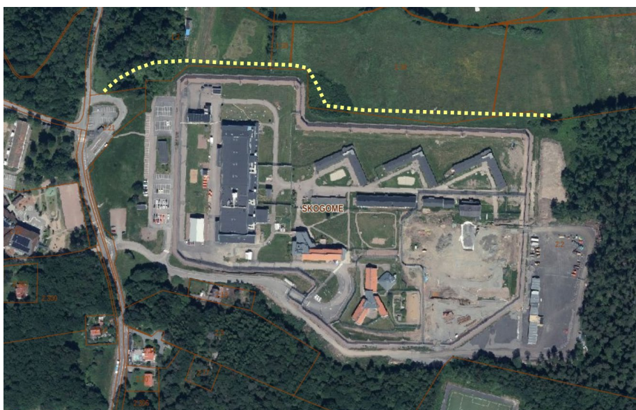
Figur 4: Schematisk sträckning av byggväg nödvändig för projektets genomförande.
