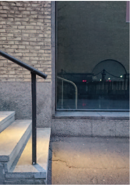
Distinkta materialmöten mellan tegelfasaden och de låga socklarna av granit, samt inramningar i sten kring öppningar i tegelmuren.
