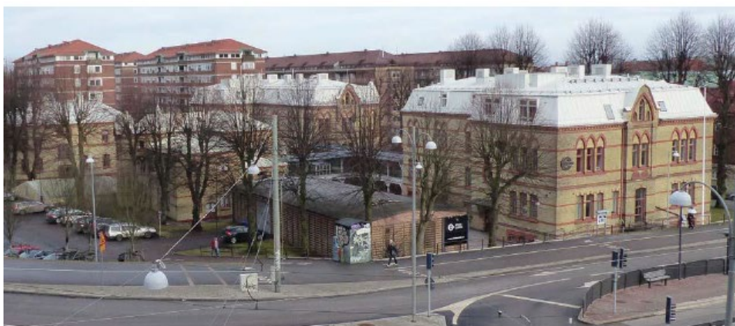
Bildtext. Före detta Holtermanska sjukhusbyggnaden sett från söder (Waern landskap).
