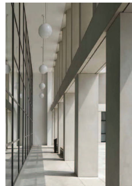
Fasaden får en robust och högre entréportik med omsorgsfullt utformade pelare.
