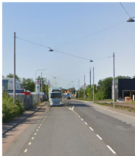
Figur 16: Spännstolpar för linspändbelysning, vegetation och staket inom säkerhetszonen
