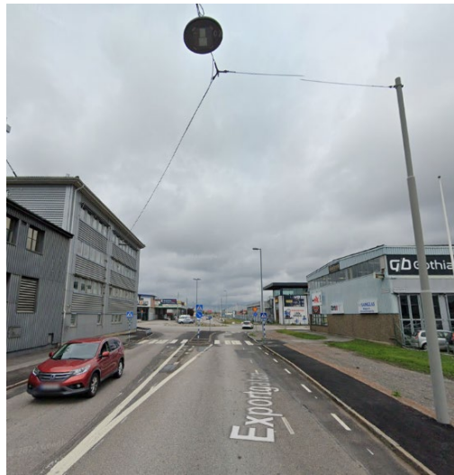
Figur 14: Spännstolpar och byggnader inom säkerhetszonen
