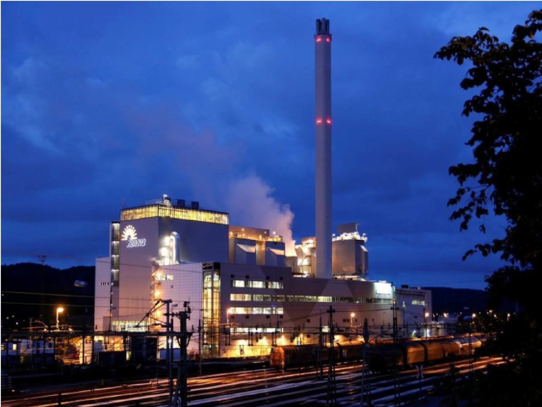
Kvällsvy över Renovas befintliga avfallskraftvärmeverk i Sävenäs
