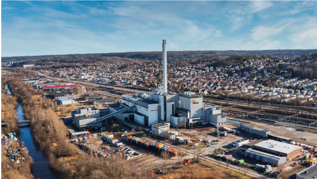
Befintlig anläggning, sett västerifrån. Bild: Renova
