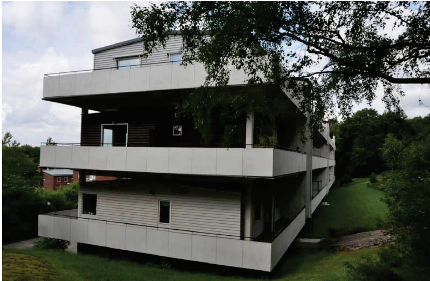
Däckshus i Kallebäck, Erik Friberger 1960 Betongstomme i 3 våningar med trapphus. "Tomter" på betongplattan där de boende själva fick bygga sitt hus.
