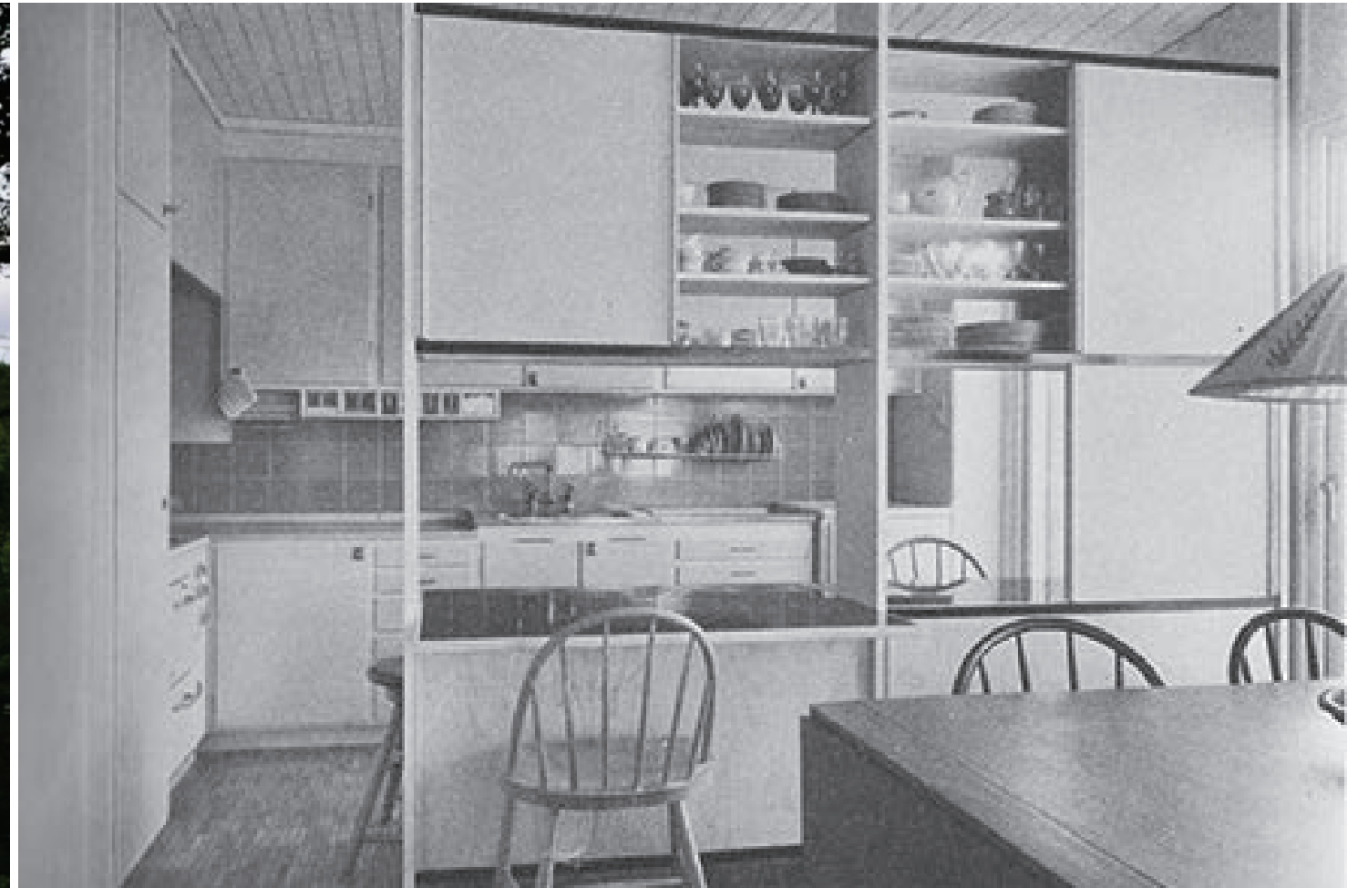
Experimenthus i Järnbrott, Tage & Anders William-Olsson 1954. Rationell betongsstomme med fast kök mot lgh-skiljadne vägg + fast badrum. Resten av rummen kunde de boende bygga upp enligt önskemål av flyttbara väggelement. Lägenheterna var en stor succé och folk bodde kvar länge pga flexibiliteten i planlösningen. För att se en kort film om projektet:
