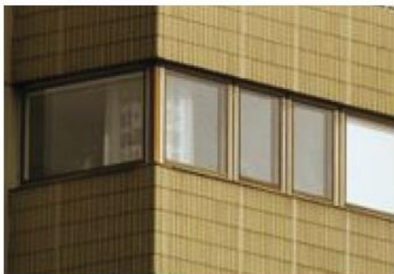
Originalfönster, yttre fönsterkarmar klädda med ljusgul eloxerad aluminium lika den på kopplade pelare.
