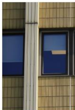
Originalpilaster klädd med eloxerad aluminiumplåt. Pigmenten har blekts med åren.
