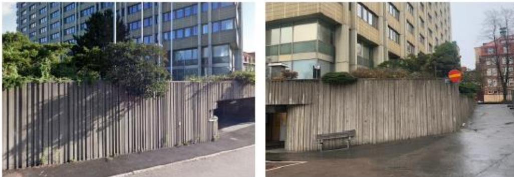
Befintlig betongbalustrad, Wingårdhs, år 2021
