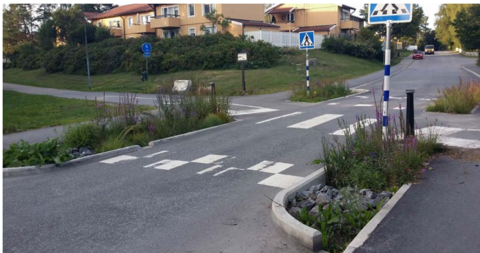
Figur 4.18. Exempelbild på regnbädd i refug från Gestaltning av dagvatten - Exempel och framgångsfaktorer (Banach m.fl, 2015).
