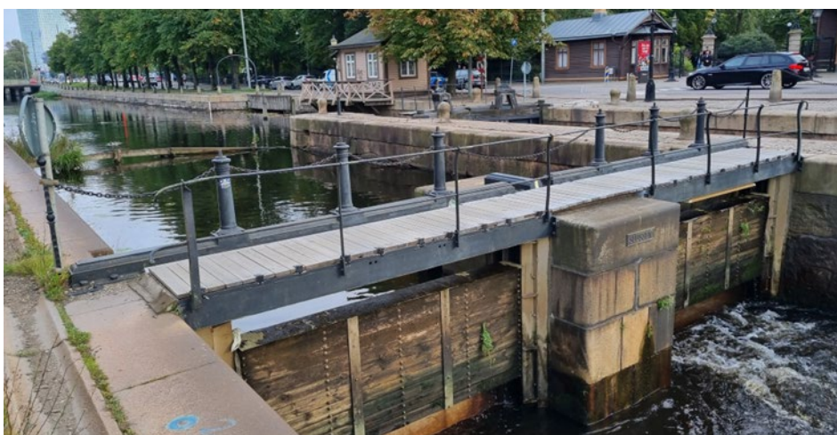
Figur 4.4 Slussen som reglerar vattennivån i övre delen av Fattighusån.
