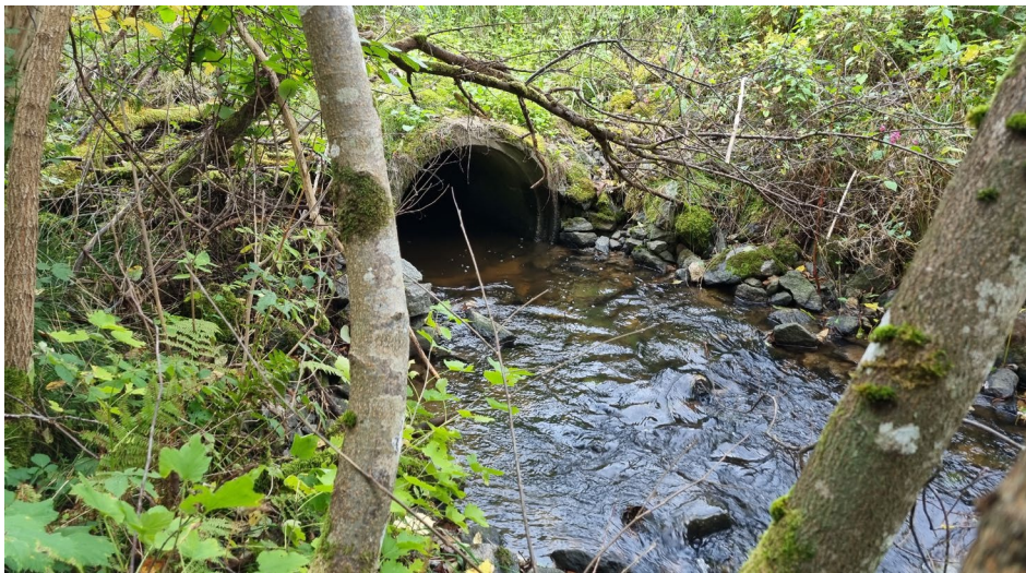
Figur 4.18 Trumman under Rosenhöjdsvägen.
