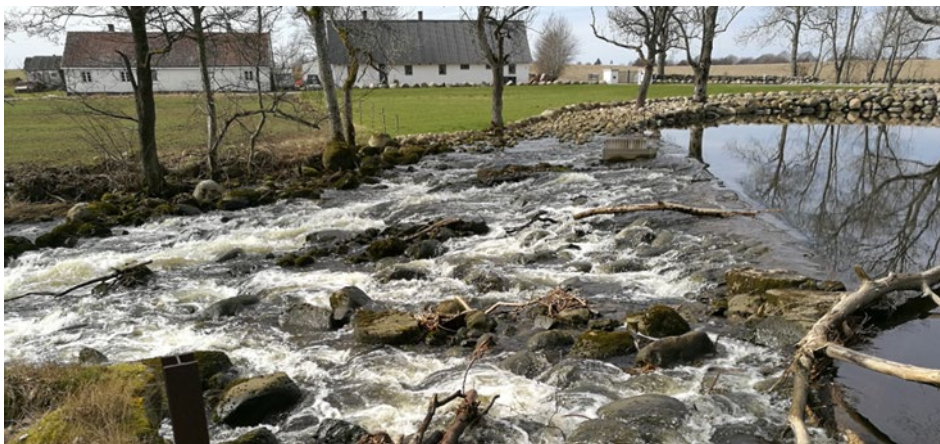
Figur 2.2. Äldre dammar utgör ofta vandringshinder i vattendragen och kan även minska den naturliga transporten av sediment och organiskt material i vattendraget. Bild från Vollsjöån.
