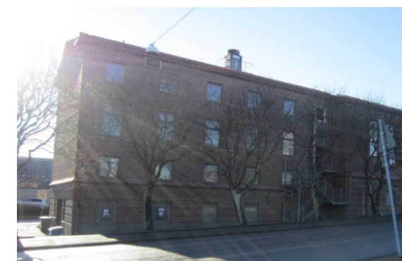
GS-hallen, fasad mot norr och gavel mot nordöst
