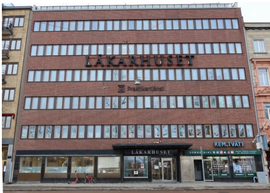
Befintlig byggnad, fasad mot Södra Vägen
