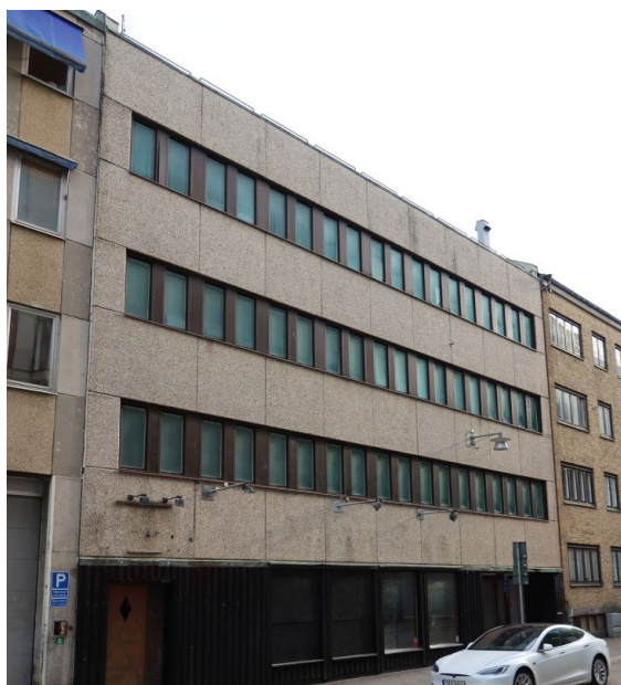
Befintlig byggnad, gatufasad
