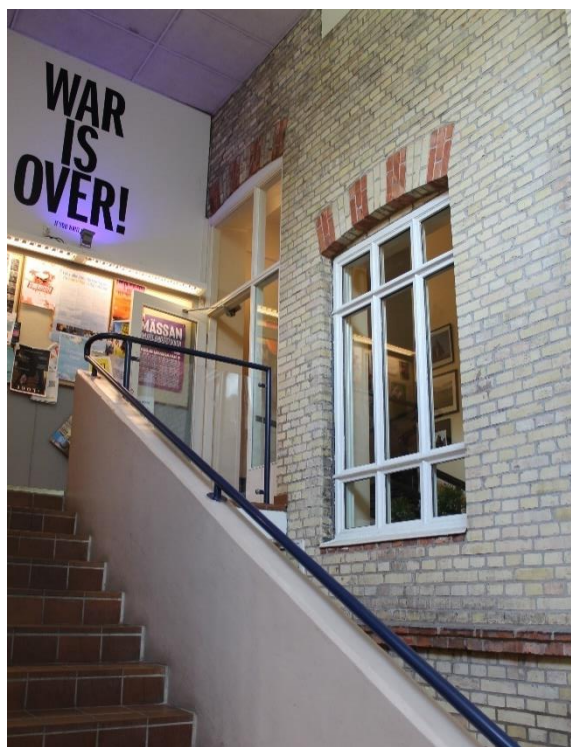
En trappa leder upp till huvudtrapphuset där ett fönster byggts om till passage. intill den bevarat trapphusfönster.
