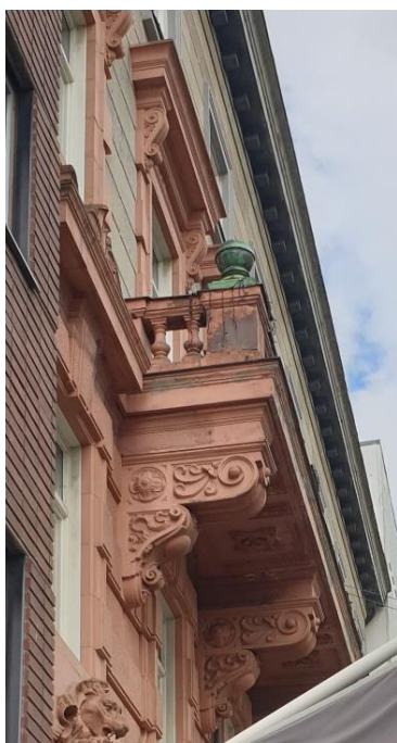
Paradbalkong med kraftiga konsoler och en undersida med fältindeldad pustornamentik. Räcke med balusterdockor mellan kraftigare stolpar. Stolparna kröns av kopparklädda klot, i originalutförande.
