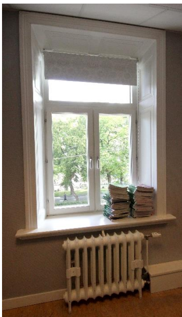
Fönsteromfattningar och gjutjärnsradiatorer i original.
