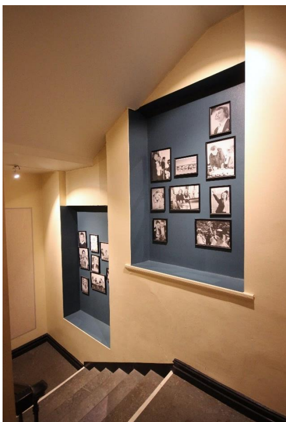
Trapphusfönstren mellan plan 2 och 3 är igenmurade med bevarade putsade smyggar. Bakom ligger gårdstillbyggnadens fläktrum
