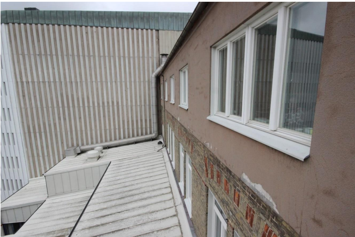
Vy från fjärde våningens balkong. Påbyggnaden har fasader i putsad lättbetong i rosa kulör samt utbytta fönster. Under fjärde våningen syns den ursprungliga tredje våningens gårdsfasad med tegel i originalutförande och utbytta fönster.
