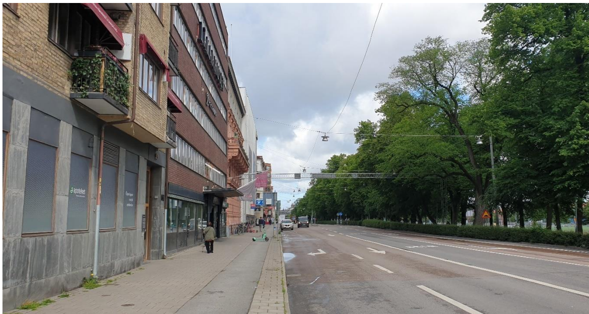
Tingshuset paradbalkong skjuter ut över trottoaren och gör att byggnaden utmärker sig i gatumiljön, jämte de släta 60-talsfasaderna.
