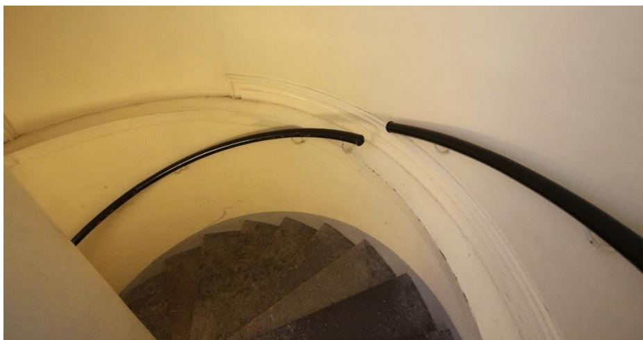
Rundat trapplopp och handledare i originalutförande.
