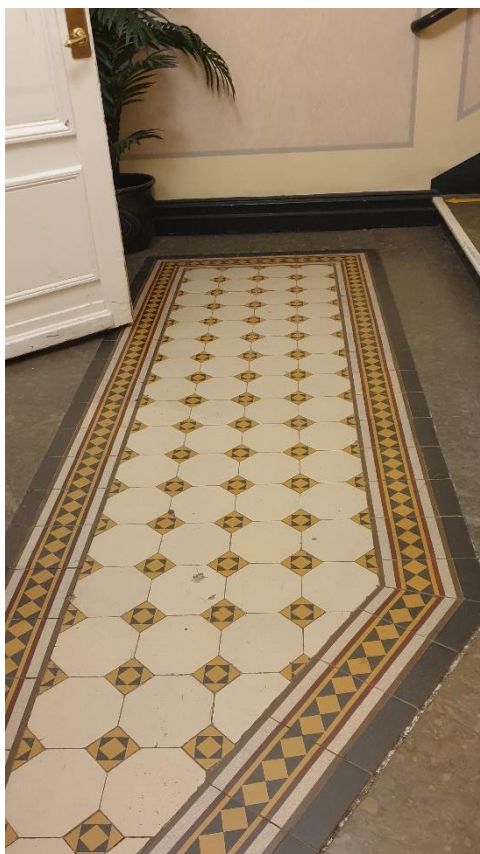
Ursprungliga mönstrade tiles med bård i kalksten.
