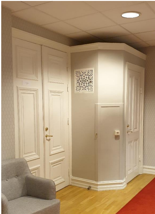
Dörr och platsbyggt skåp samt gjutet ventilationsgaller i originalutförande.
