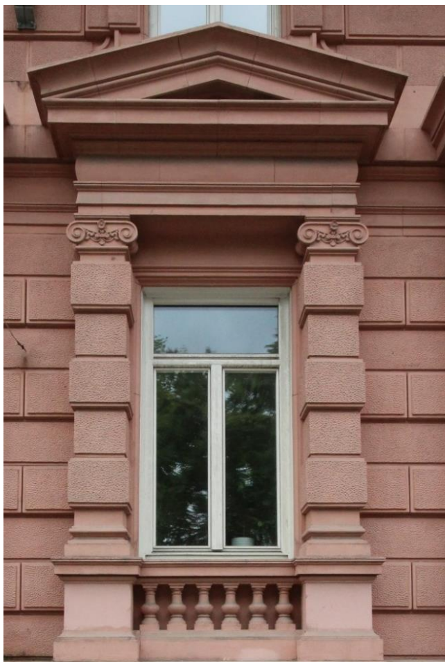
Utbytta fönster med indelning lika de ursprungliga.
