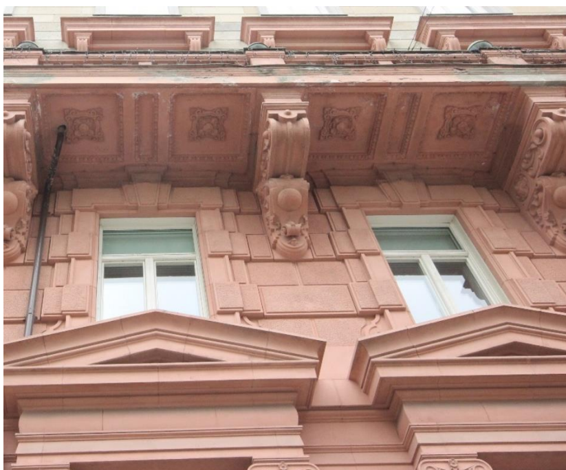
Paradbalkong med kraftiga konsoler och en undersida med fältindeldad pustornamentik. Räcke med balusterdockor mellan kraftigare stolpar. Stolparna kröns av kopparklädda klot, i originalutförande.
