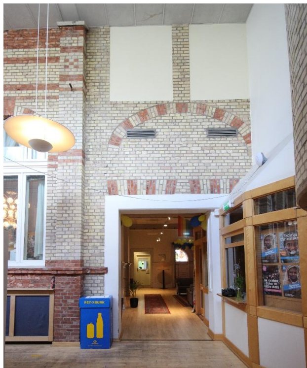
Det ursprungliga välvda fönstret mot förrummet ersattes med fyra mindre fönster då ett bjälklag etablerades på 1920-talet. Dessa fönster sattes igen/ byggdes om till passage 1987.
