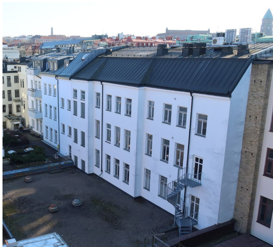
Gårdsfasaderna tillhörande Lorensbergsgatan 18 och 20.
