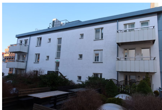
Gårdsfasad med uteplats ovanpå den överbyggda gården.
