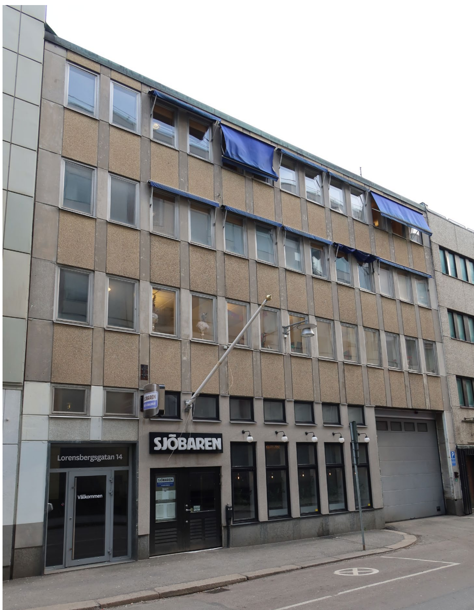
Byggnadens fasad åt Lorensbergsgatan.
