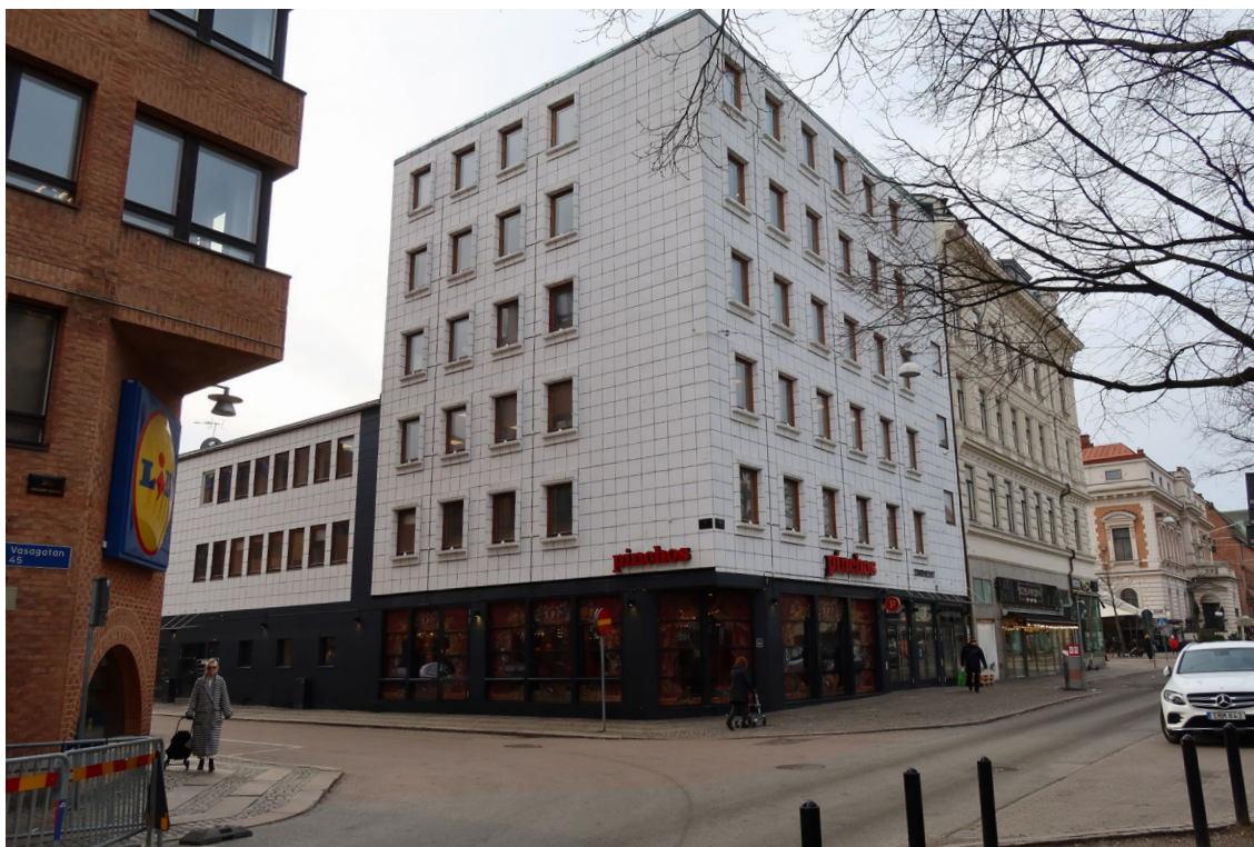
Byggnaden sedd från Vasagatan.
