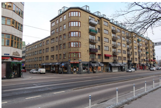
Omsorgsfullt utformad 1930-talsbebyggelse som är väl anpassad till förhållandet mellan byggnadshöjd och gatubredd.
