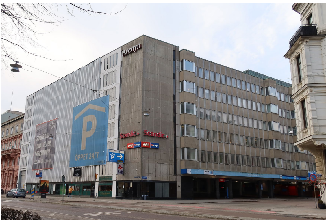
Byggnadens nordöstra hörn, vy från Södra Vägen.
