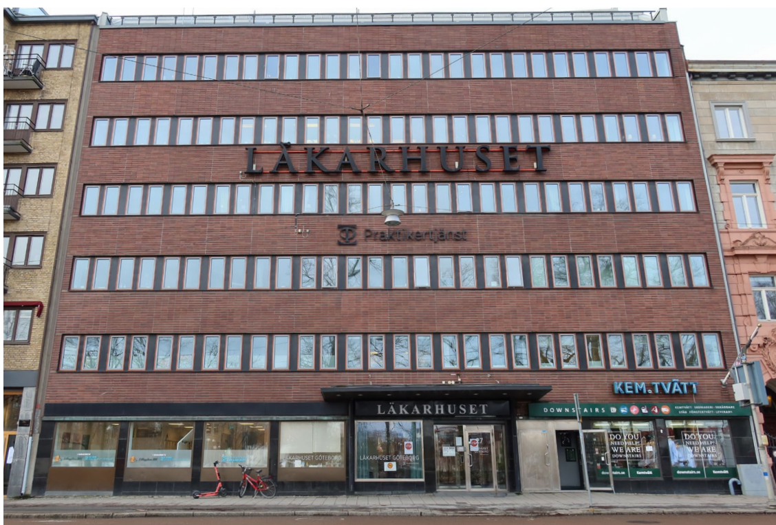
Byggnadens fasad åt Södra Vägen.
