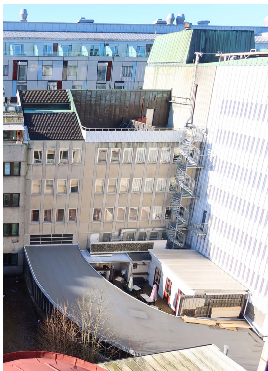
Gårdsfasaden med takterrass och nedfart till parkeringshuset.
