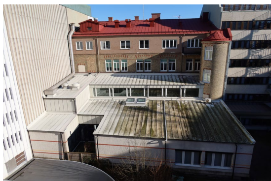
Byggnadens gårdsfasad, med tillbyggnad och trapphus.
