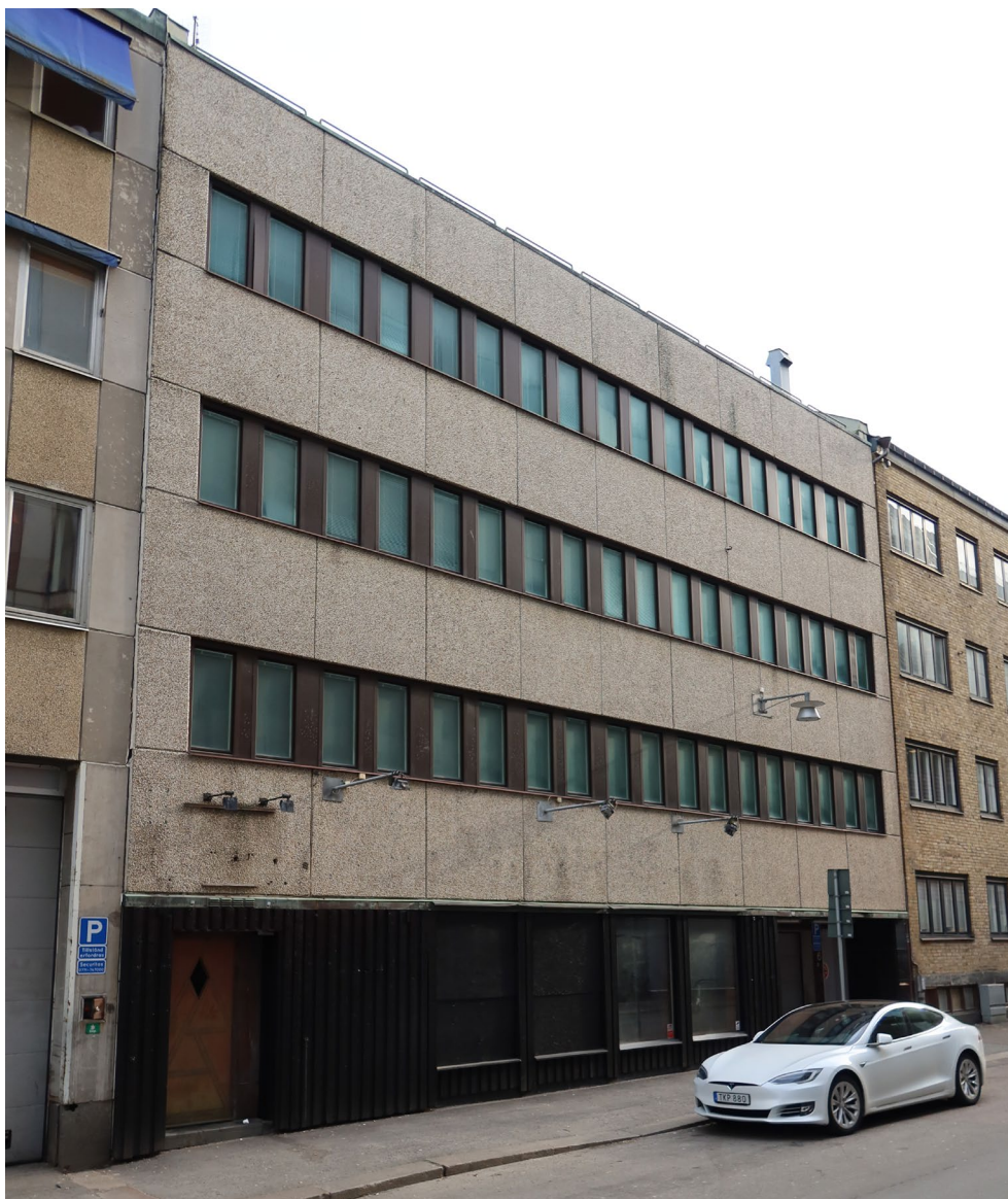
Byggnadens fasad åt Lorensbergsgatan.
