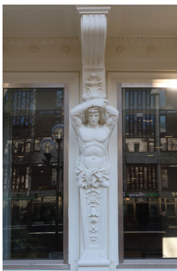
Detaljbild på en av byggnadens atlanter.
