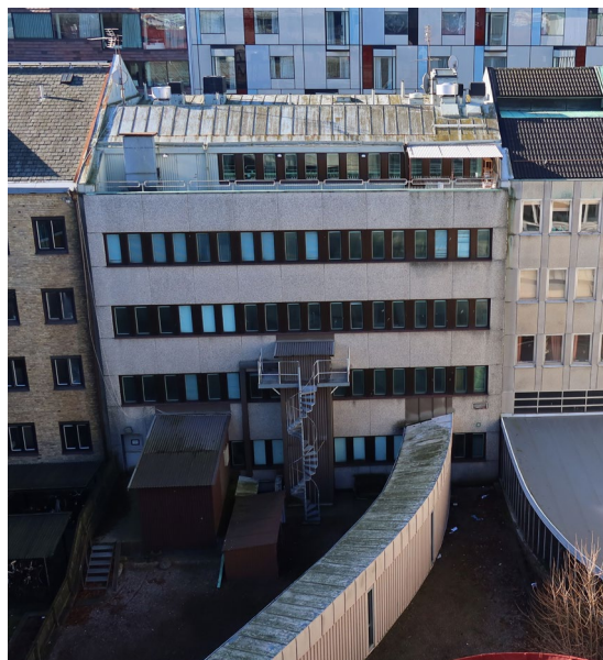
Gårdsfasaden med takterrass och förbindelsegång.
