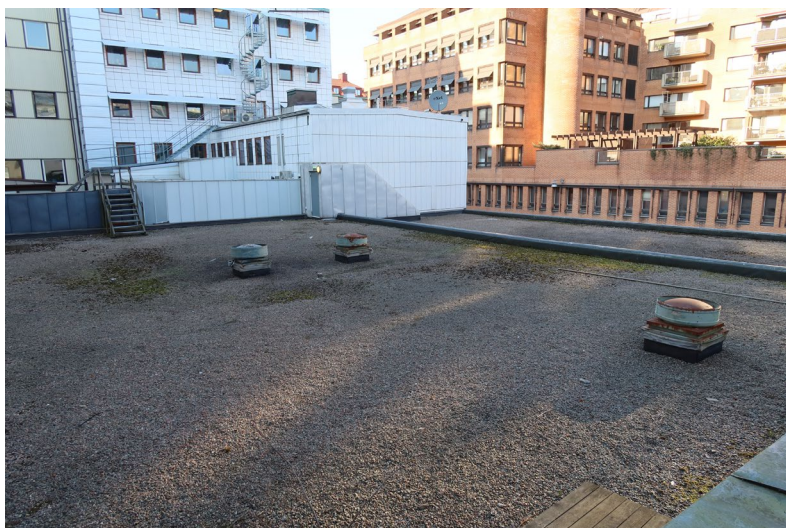
Vy över byggnadens gruslagda tak.
