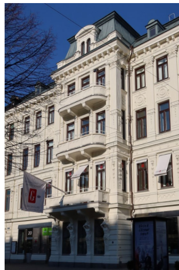
Detaljbild på byggnadens mittrisalit.
