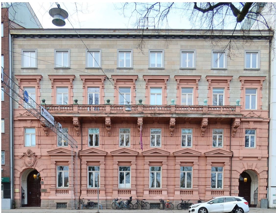
Byggnadens fasad åt Södra Vägen.
