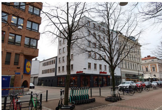
Omsorgsfullt utformad 1960-talsbebyggelse som är väl anpassad till förhållandet mellan byggnadshöjd och gatubredd.
