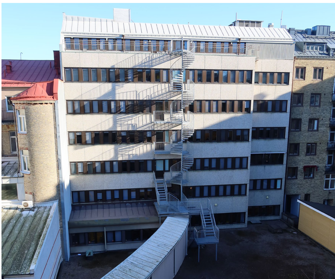
Byggnadens gårdsfasad, med förbindelsegång.
