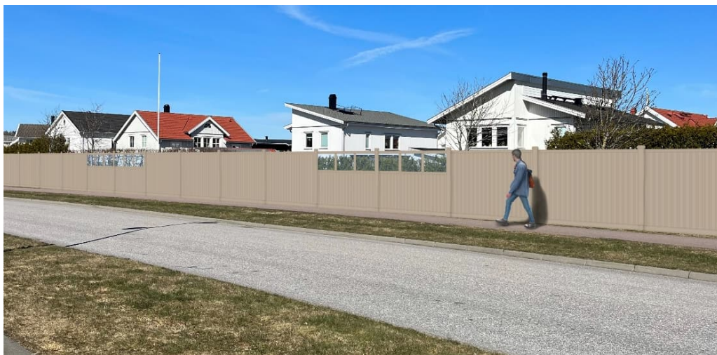
E.1:36 Visualisering av en 1,8 m hög bullerskärm.
