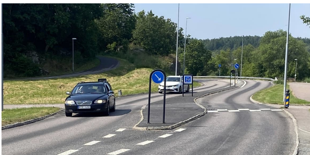
E.1:33 Exempel på utformning av hastighetsdämpande "port".
