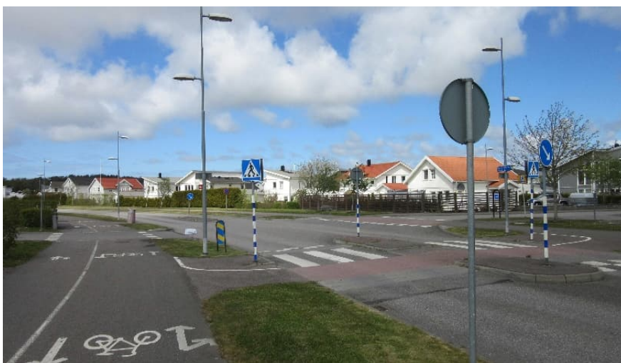
C.3:8 Nya Älvegårdsvägen, exempel på hastighetssäkrad passage.
