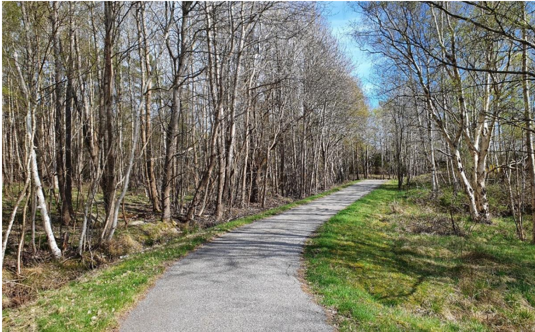
Befintlig gång- och cykelväg som ligger skilt från Bulyckevägen. Sträckningen kommer att ligga kvar men breddas från ca 2,5 meter till 4,5 meter (Norconsult)
