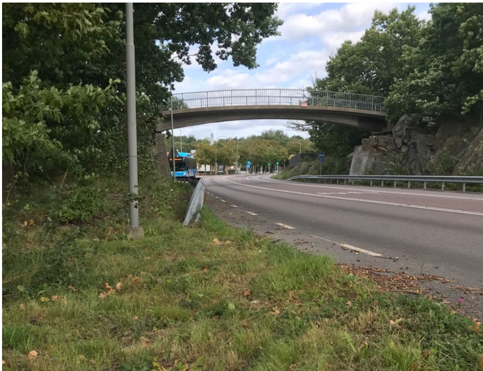
Figur 10. Bild från platsbesök (2023.09.21).
