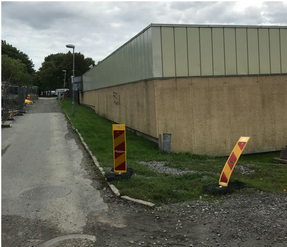
Figur 13. Bild från platsbesök (2023.09.21).
