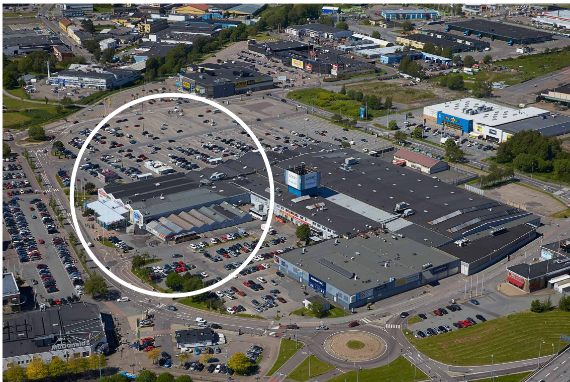
Äldre industribebyggelse inbyggd i befintligt köpcenter
