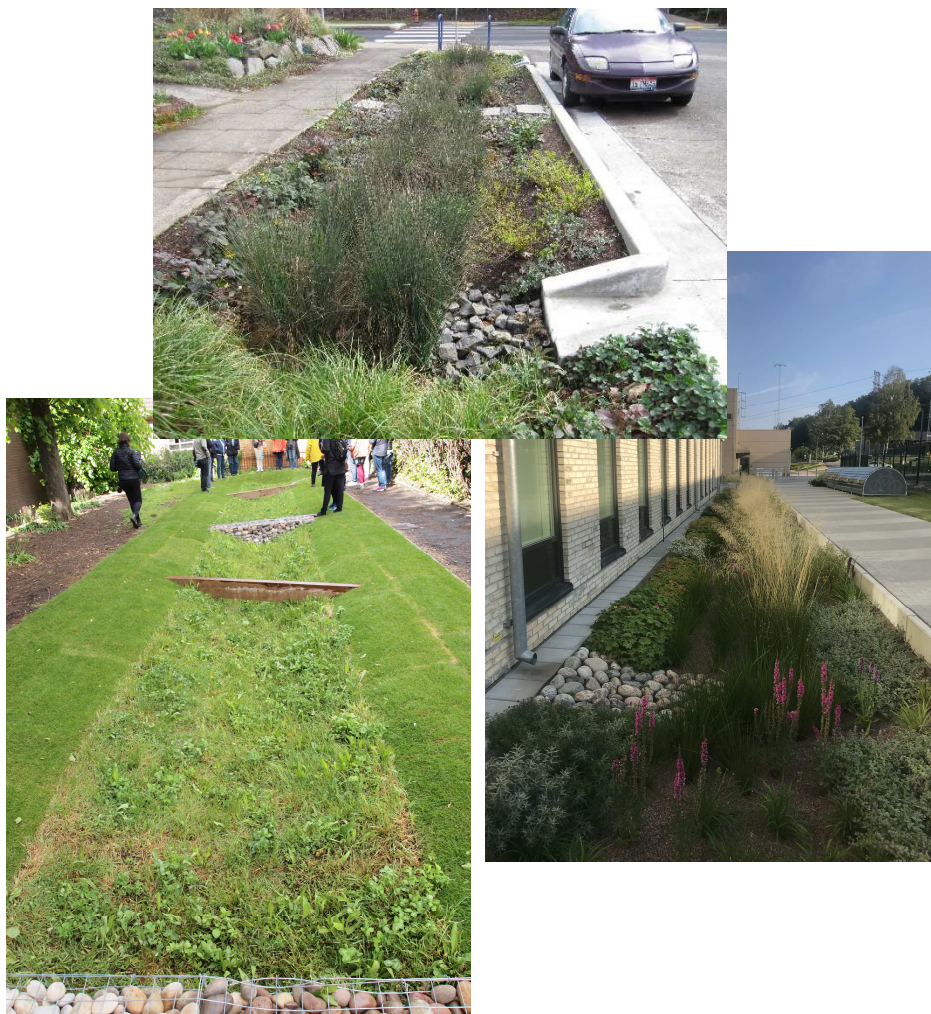
Figur 19 Visar exempel på olika former av biofilter/växtbäddar.
