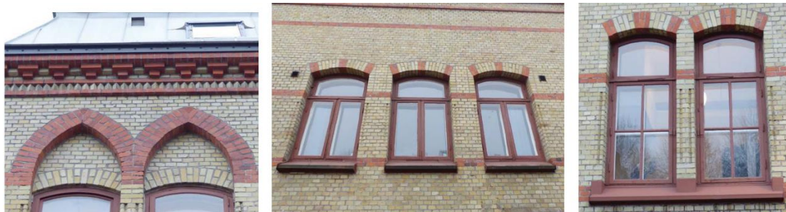
Detaljer med plåttak med takfönster, mönstermurat tegel i gult och rött samt ursprunglig fönsterindelning av två olika typer.
