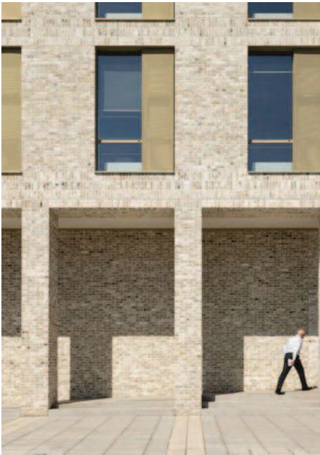
Fasadens släta tegelmur får välstuderade detaljer kring öppningar.
