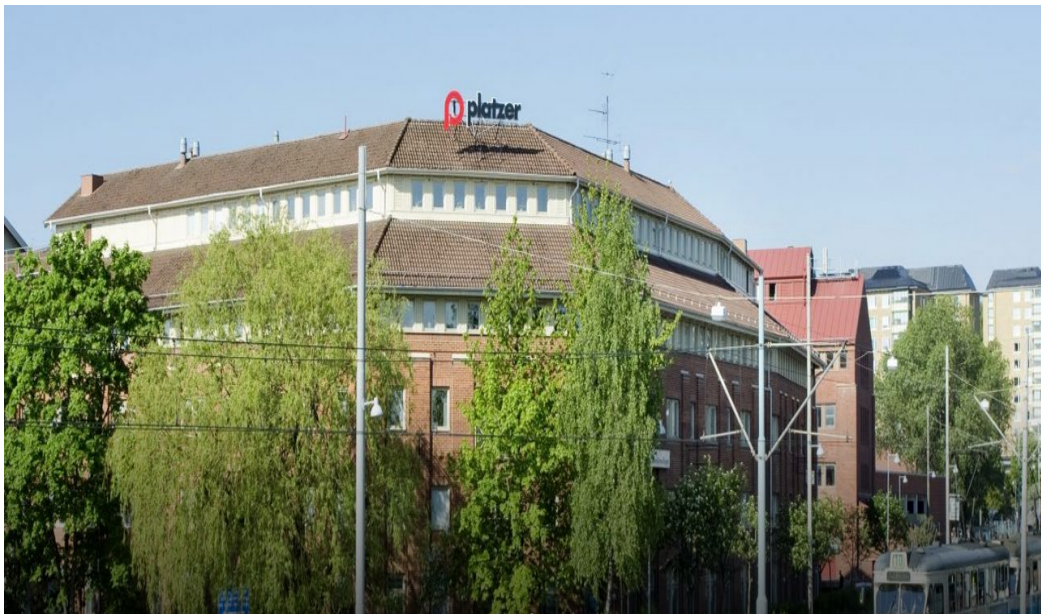
Figur 3 visar byggnaden exteriört från nordöstrasidan där spårvagnen går
