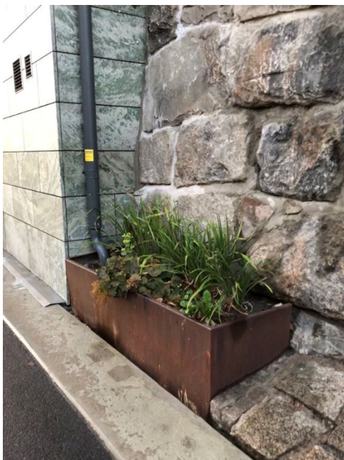
Figur 28 Upphöjda regnbäddar som avleder takvattnet via stuprör, Sweco Dagvatten- och skyfallsutredning.
