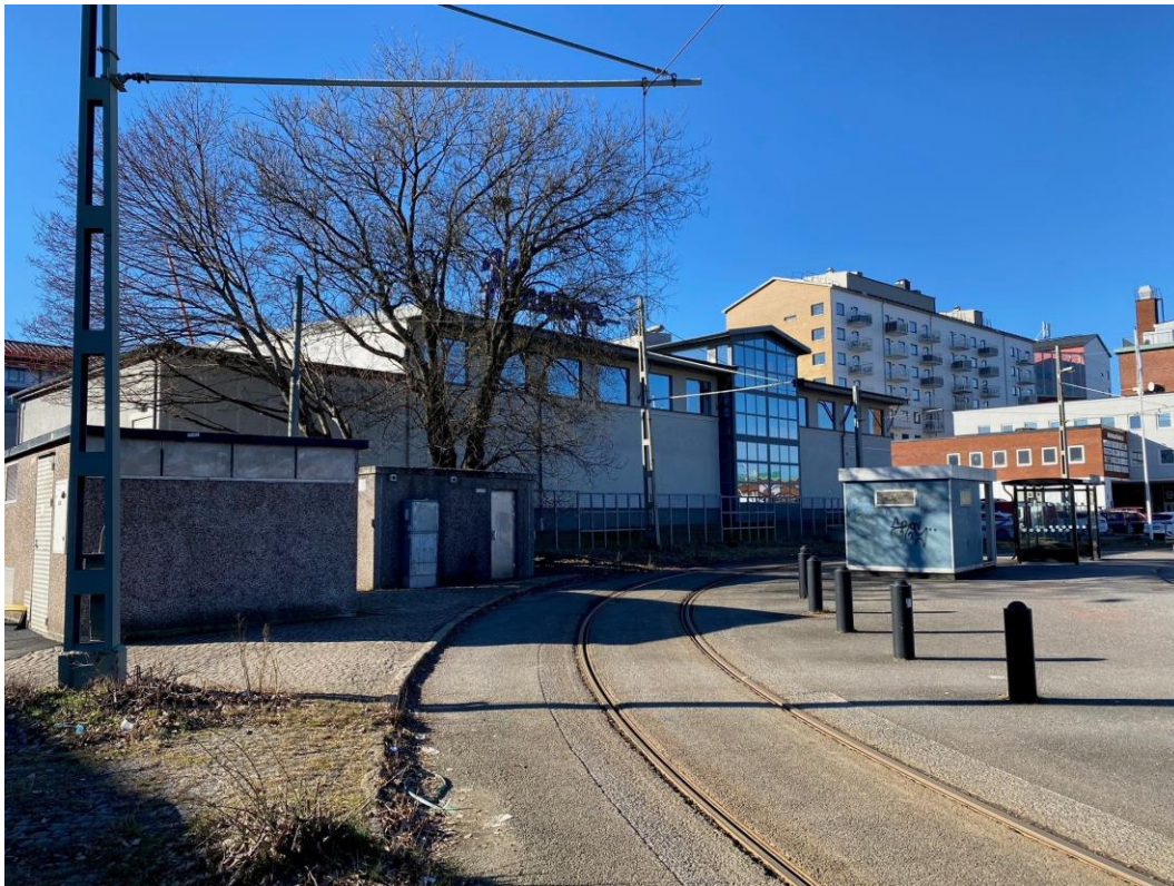
Figur 8: Platsfoto från 2023 som visar spårvägens vändslinga vid Lana och befintlig kontorsbebyggelse inom planområdet. I fonden syns bebyggelsen norr om planområdet.
