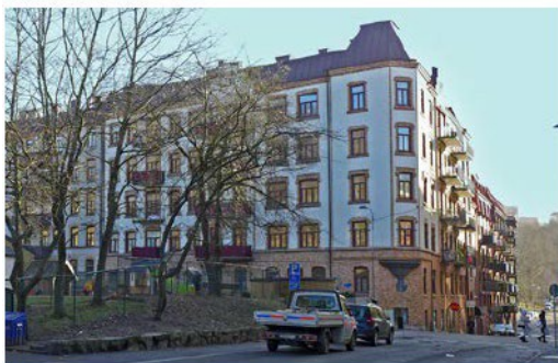
Figur 5. Fasad mot Kastellgatan. Foto Antiquum AB.
