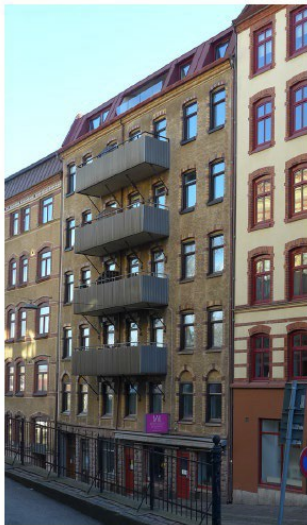
Figur 8. Fasad mot Kastellgatan. Foto Antiquum AB.
