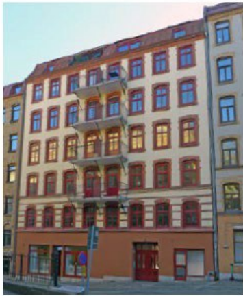
Figur 7. Fasad mot Kastellgatan. Foto Antiquum AB.
