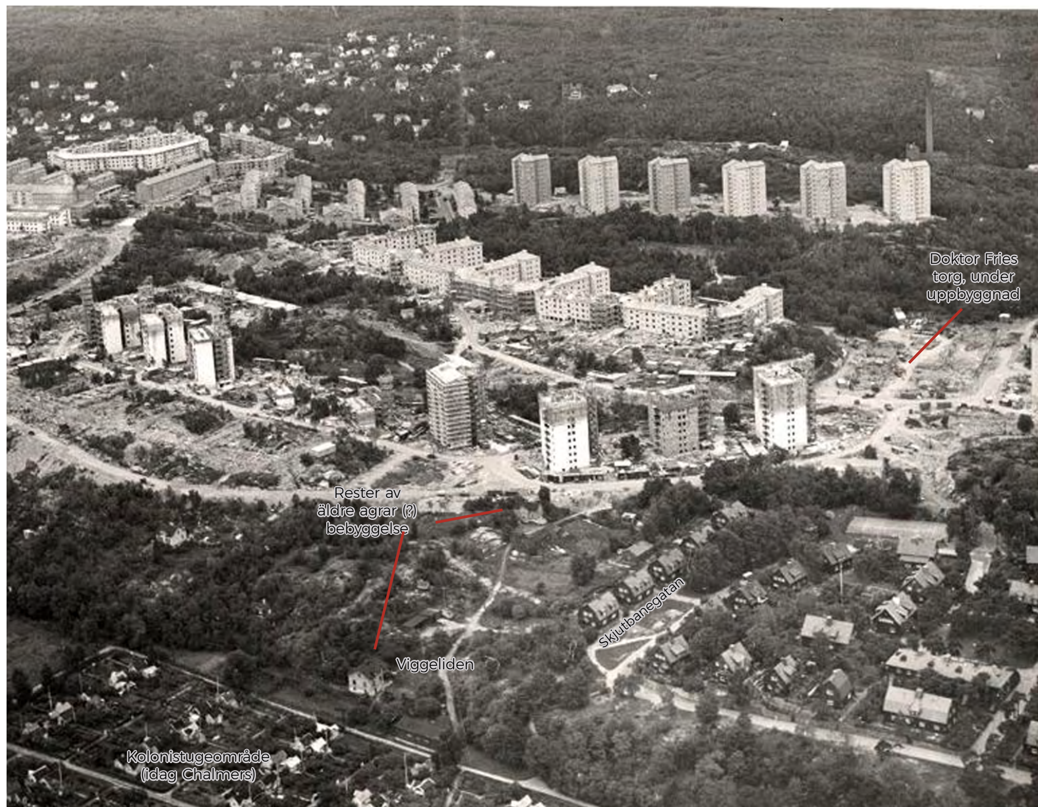
Byggande av Södra Guldheden, fotografi taget år 1951. Som ett stråk i mitten av bilden löper Viggeliden upp mot den nya stadsdelen. Kring Landala egnahem den grönskande parkgördeln. Då stod träden betydligt glesare och grönskan hade en mer parkliknande karaktär mot kolonistugeområdet (Chalmersområdet idag). Hämtad från Stadsmuseets databas Carlotta, ID nummer: GSMArkiv:140087, sökning: Landala egnahem. Licens: public domain-märke 1.0.
