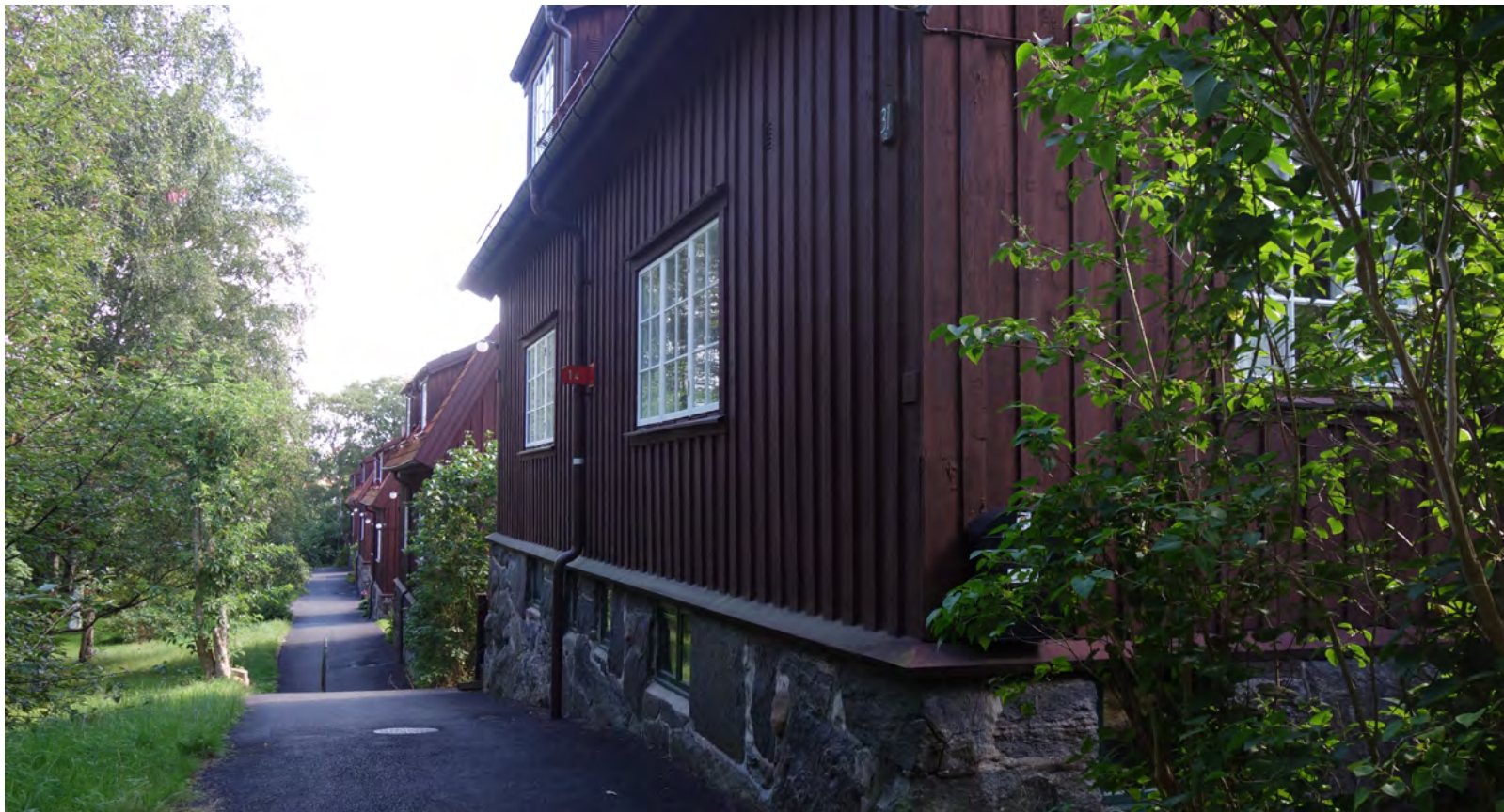
Hyreshus vid Skjutbanegatan, uppförda 1917.
