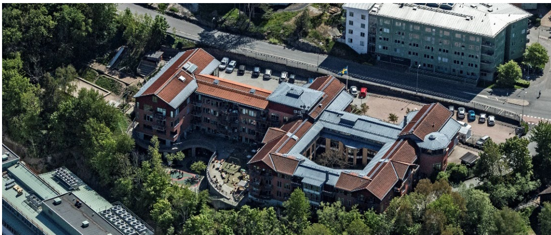
Figur 54 Flygvy över befintlig byggnad. Skolgårdar/friyta för barn syns mitt i bild samt till vänster i bild.
