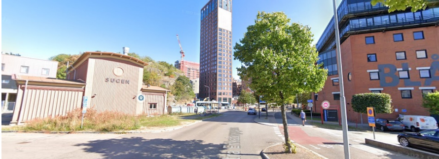
Östra Eriksbergsgatan österut, sopsugsstationen till vänster
