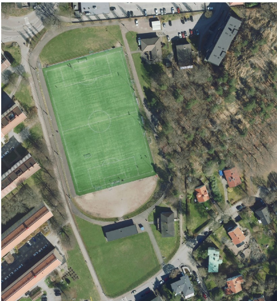
Figur 13. Ortofoto över Överåsullen och tillhörande byggnader.
