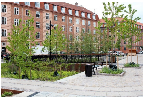
Tälinge plats, Köpenhamn. En före detta parkering har gjorts om till en multifunktionell yta för dagvatten- och skyfallshantering samt rekreation. Bildkälla: Klimakvarter. dk/projekt/tasinge-plads
