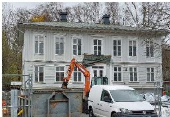
Objekt: Gibraltar Herrgård Gatuadress: Orrspelsgatan 16 Fastighetsbeteckning: Krokslätt 110:3 (4)
