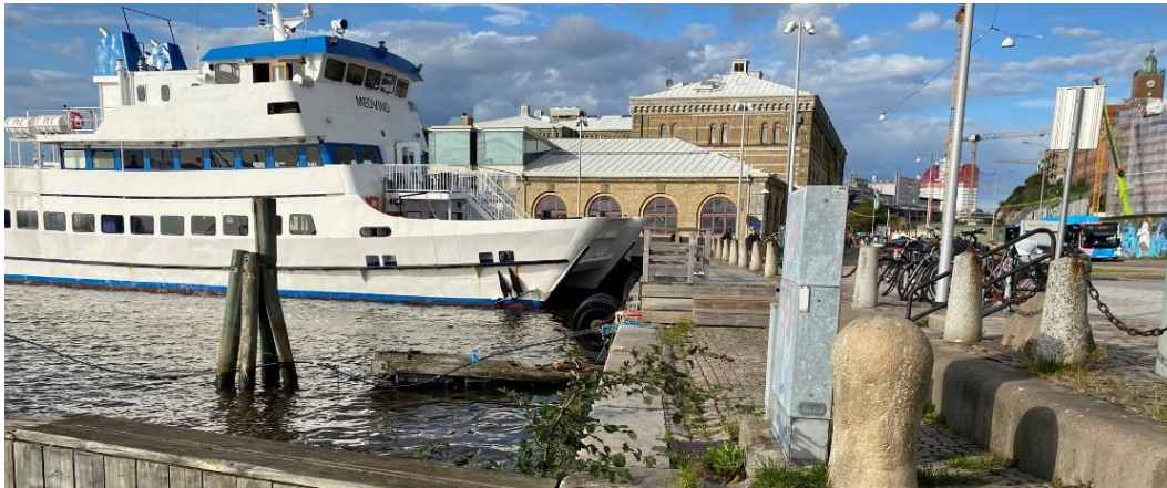
Figur 30 Lägre parti av kajen mellan svängbron och den renoverade kajen. Kajkant, gatsten och pollare i granit.
