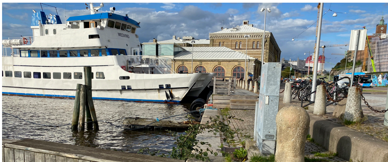
Ovan: Den nyligen förstärkta och ombyggda Packhuskajen, med kajkant och gatsten i granit, samt Stora Tullhuset till höger. Nedan: Lägre parti av kajen mellan svängbron och den renoverade kajen. Kajkant, gatsten och pollare i granit.
