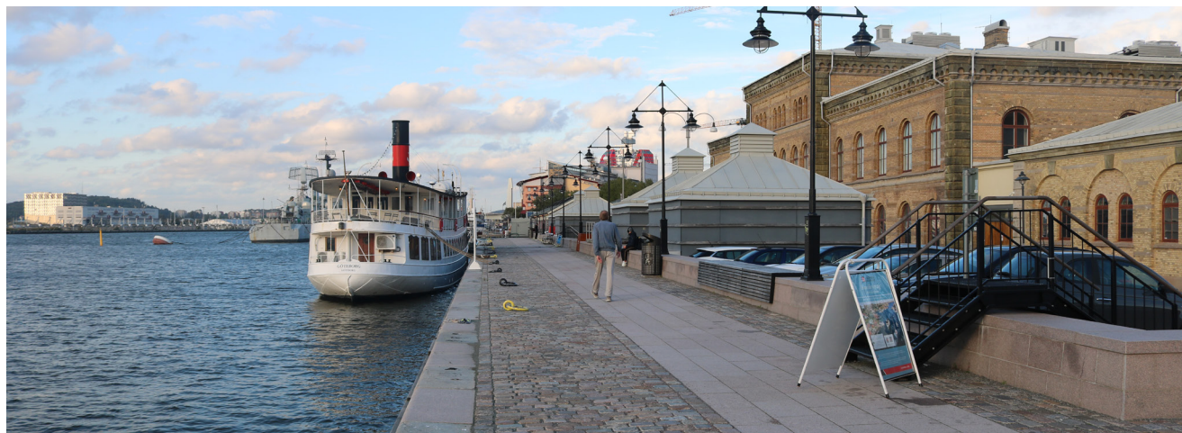
Ovan: Den nyligen förstärkta och ombyggda Packhuskajen, med kajkant och gatsten i granit, samt Stora Tullhuset till höger. Nedan: Lägre parti av kajen mellan svängbron och den renoverade kajen. Kajkant, gatsten och pollare i granit.
