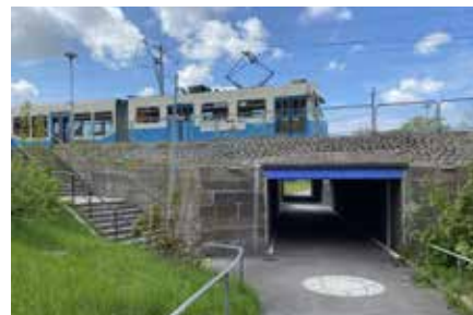
Briljantgatans spårvagnshållplats med passage såväl över som under spårvägen.
