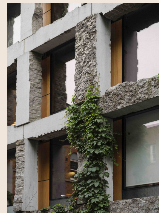
15 Clerkenwell Close i London av Groupwork och Armin Taha Architects med en rusticerad självbärande stenfasad.
