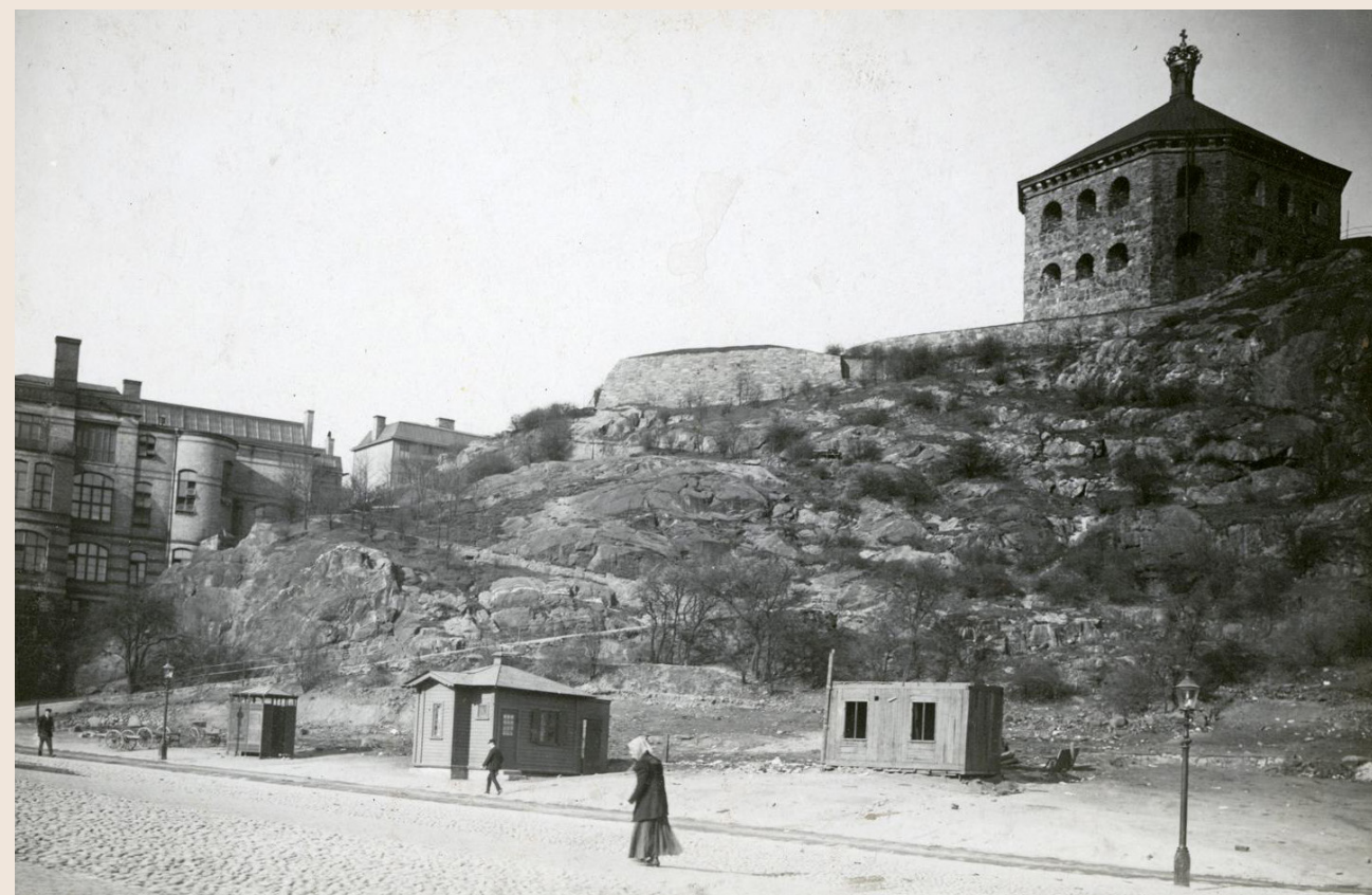
Slänten mot Skansbergets östra sida efter rivningen av de större vedskjulen 1914. (Foto Göteborgs stadsmuseum)
