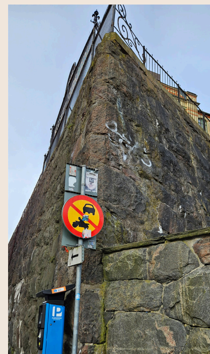
Fasad hörn på stödmur mot Korsettfabriken, Kastellgatan.
