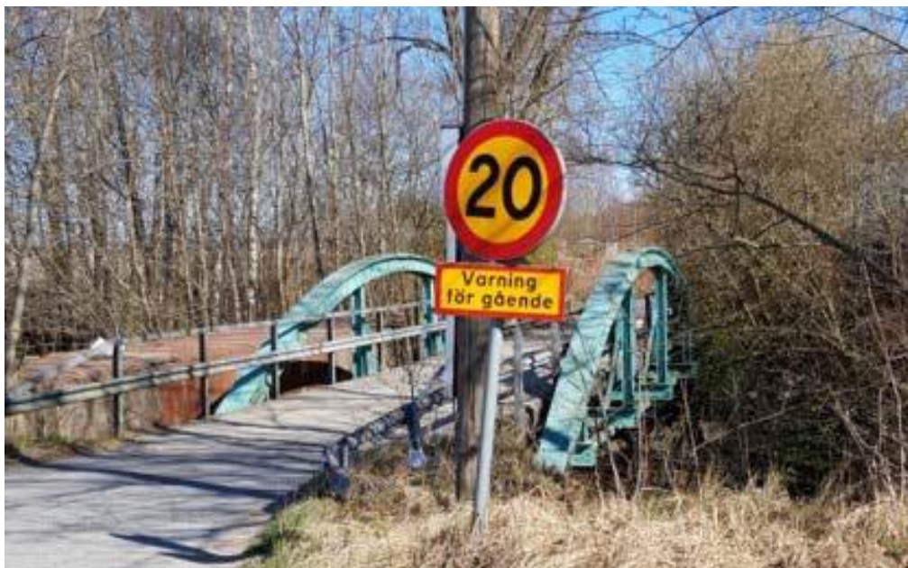
Bron över Lärjeån (Foto: Sweco)
