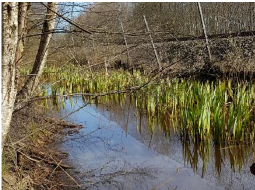
Bäck/dike längs spårvägen (Foto: Sweco)
